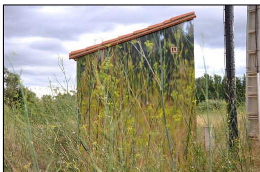
Bâtiment de surveillance des crues, Pézilla la Rivière, RD 16 A, impression numérique sur film adhésif et aluminium, 23m2
